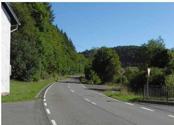
Derzeitige Kreuzungssituation Kapellenstraße / L46 (Bildquelle: eigene Aufnahme)
